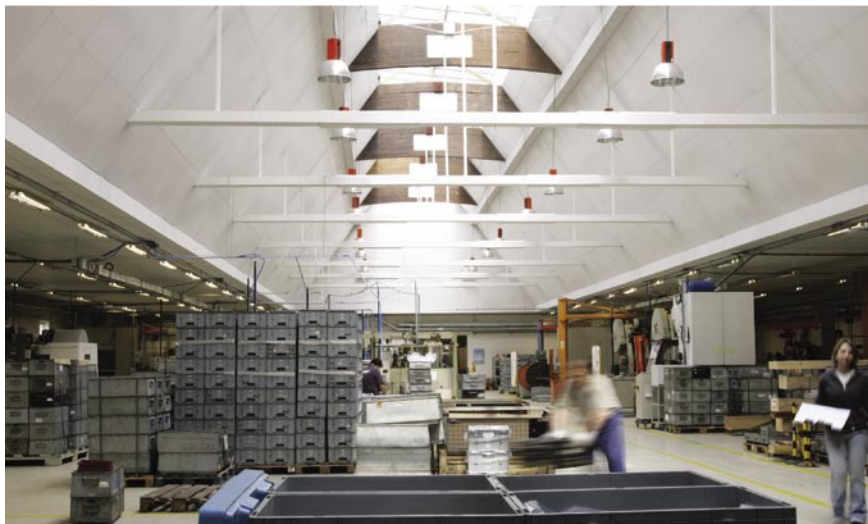
Akustický obklad Ecophon Industry Modus S 1200 x 1200 x 100 mm, Siemens, Vrchlábí
